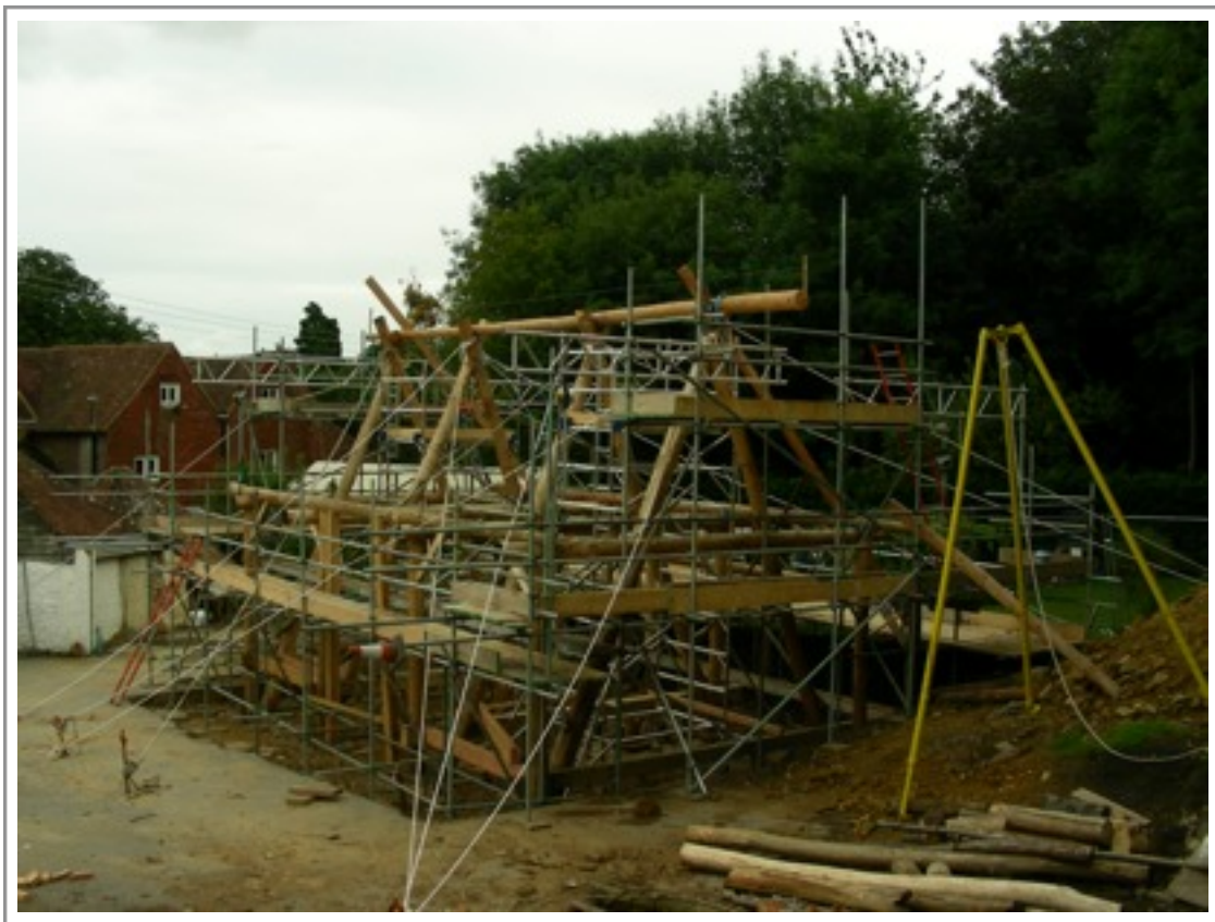
Ein Rundholzbau. Der neue Dorfladen in Lodsworth im Bau, Juli 09
